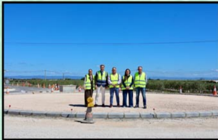
OBRAS DE LA NUEVA ROTONDA EN LA CARRETERA DE EL VILLAR Y CAÑADA DEL RABADÁN
